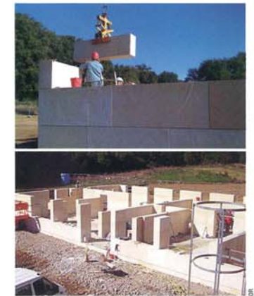
Les blocs de pierre massive sont grutés en place pour édifier les murs.
